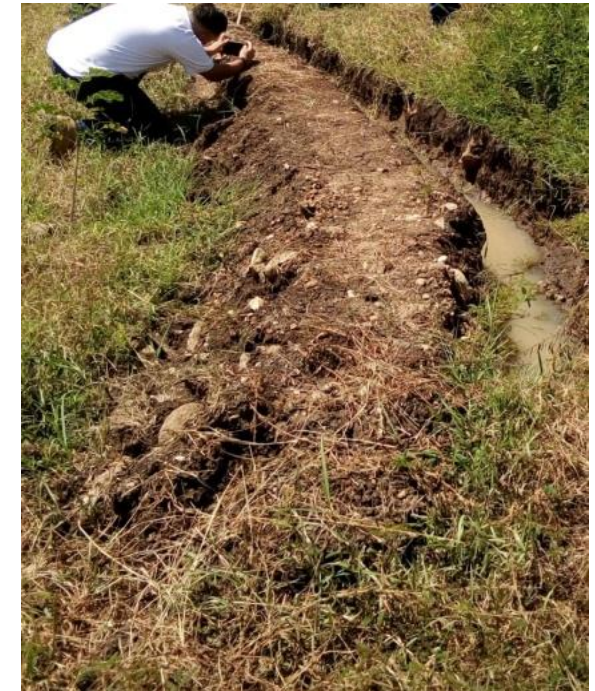
Foto. Construcción de acequias de ladera, proyecto ACUA
